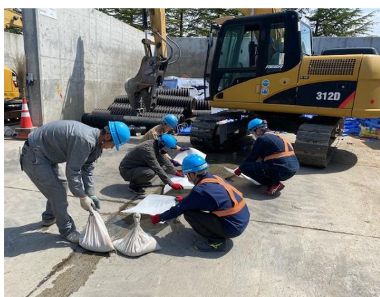
高森RCSの『油漏れ』に対する緊急事態訓練
