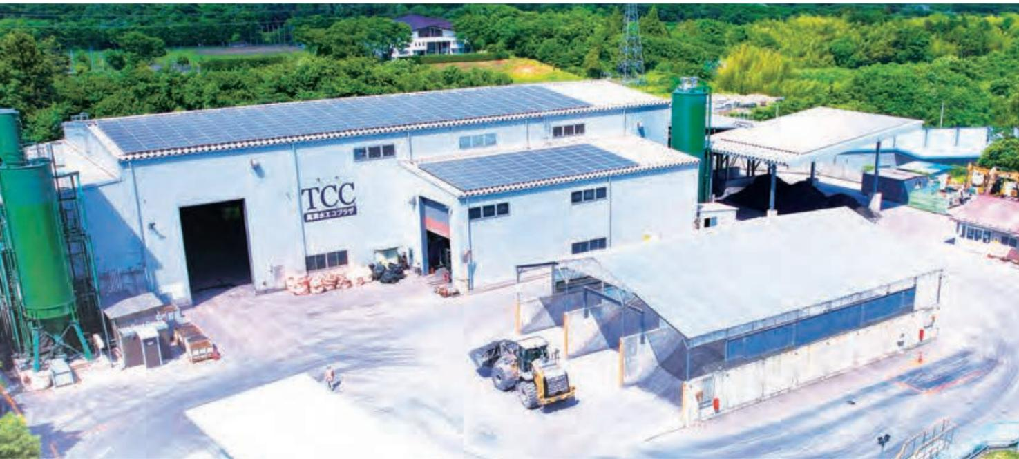
高清水エコプラザでは「リサイクル材として新たな命を」をモットーに、埋立処分されていた東北・関東地方のバイオマス発電所や焼却施設から排出される産業廃棄物及び一般廃棄物の燃え殻・ばいじんを257.8t/日の処理能力を持つ設備で受け入れ、造粒固化処理した固化物を再生路盤材料としてリサイクルすることで、限られた資源の循環とリサイクル率向上に貢献しています。
